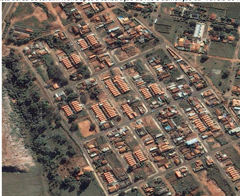
Figura 4: Vista aérea do Jardim Ivone após a construção de HIS e demolição da “Favela do Ivone” (2013)
