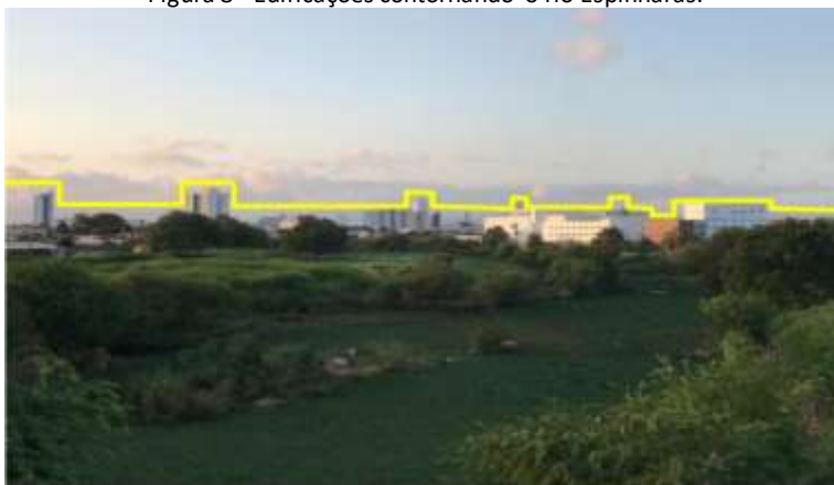
Figura 8 - Edificações contornando o rio Espinharas.
