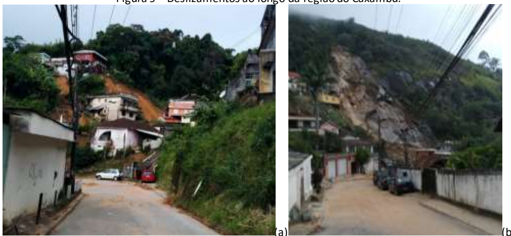
Figura 9 – Deslizamentos ao longo da região do Caxambu.
