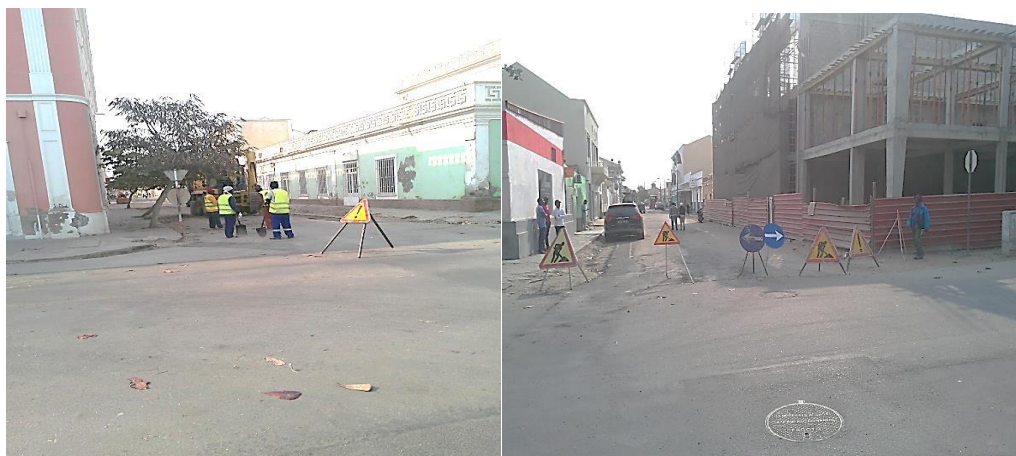
Figura 8 - Áreas de trabalho com sinalização
