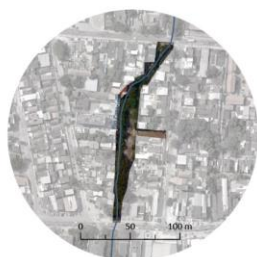
Ⓐ Calha do Rio Catarino Trecho entre R. Bernardo de Vasconcelos e Av. de Santa Cruz
