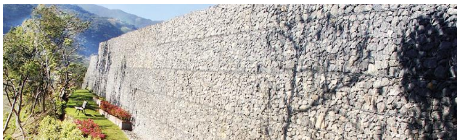
Figura 2. Estrutura de contenção feita com gabião
