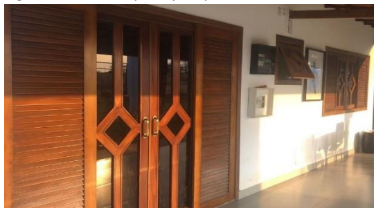
Figura 8 – Fachada principal após reforma.
