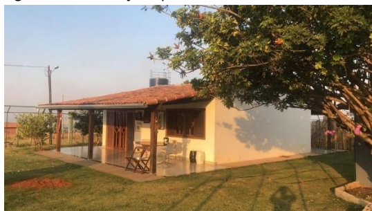
Figura 10 – Edificação após reforma.
