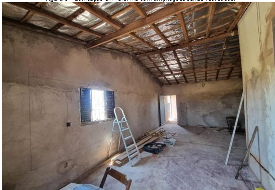
Figura 6 – Edificação em reforma com ampliações sendo realizadas.
