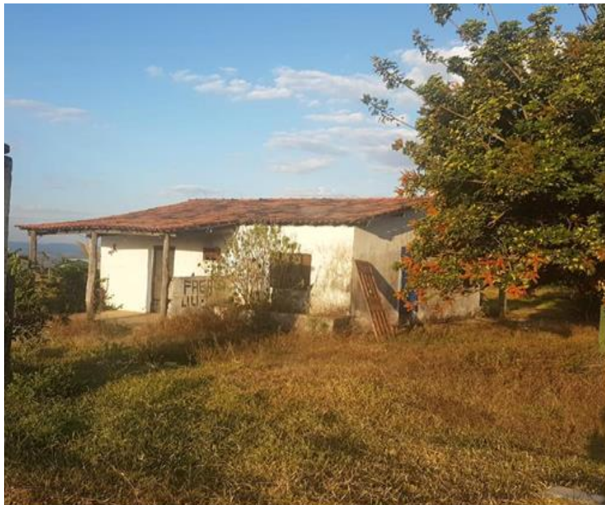
Figura 3 – Edificação existente, antes da reforma
