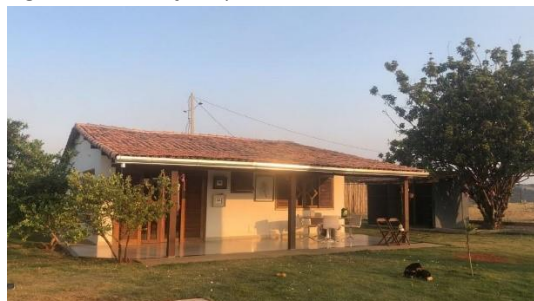
Figura 9 – Edificação após reforma.
