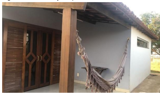
Figura 11 – Edificação após reforma.
