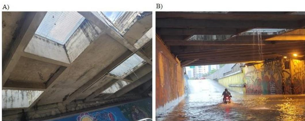
Em períodos de precipitação, os canteiros acumulam água e as direcionam para o interior do túnel, que caem em cascata pelas aberturas gradeadas, dificultando, em momentos de maior vazão, a mobilidade dos transeuntes.
