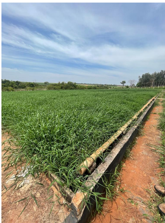
Figura 3 – Vista das baias para escoamento superficial.
