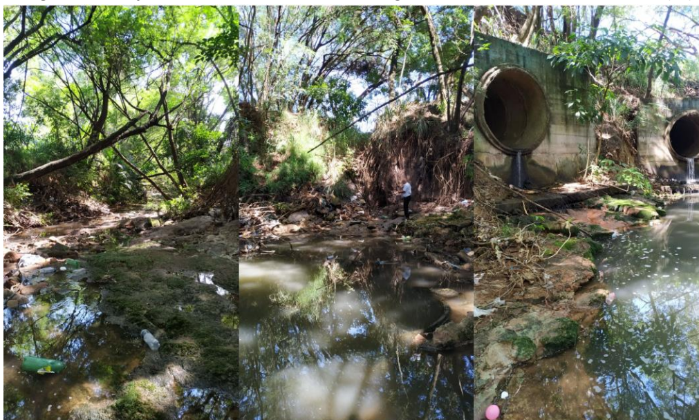
Figura 5 – Condições Ambientais no trecho 1, do Córrego Vale do Sol, em Presidente Prudente (SP).
