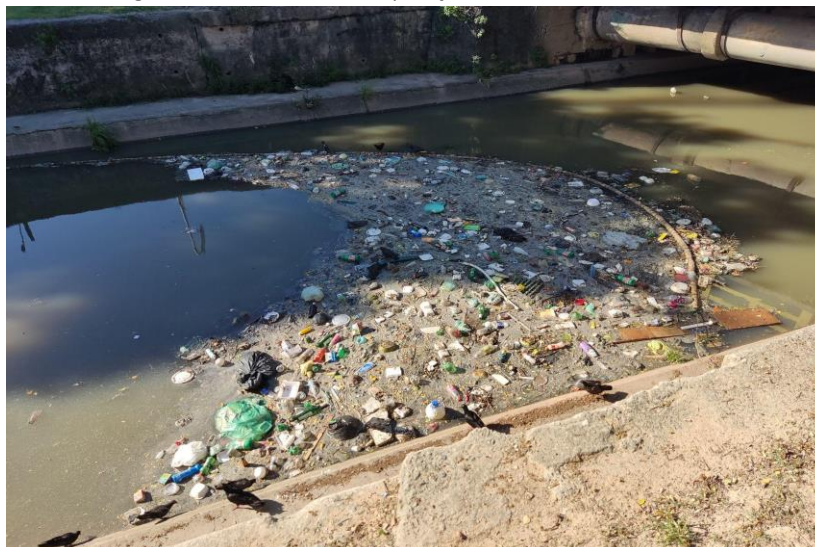
Figura 06 - Ecobarreira em operação no Canal do Aruda- 2023
