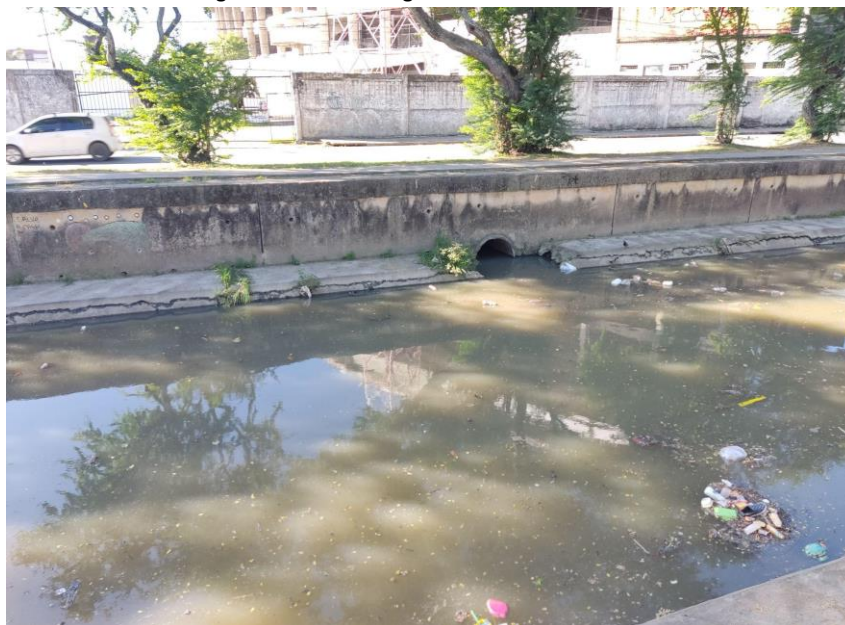
Figura 04 – Trecho e galeria do Canal do Arruda
