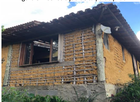
Figura 3 – Construção de taipa de pilão
