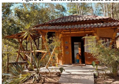
Figura 17 – Construção com base de concreto
