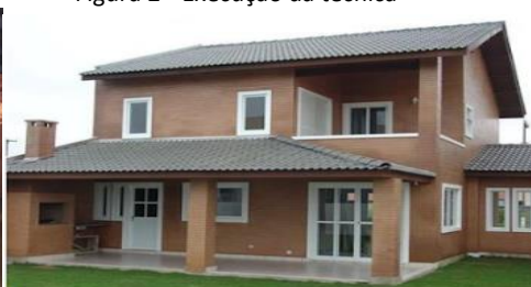
Figura 2 - Execução da técnica
