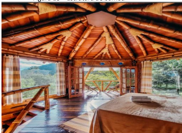
Figura 18 – Estrutura de bambu
