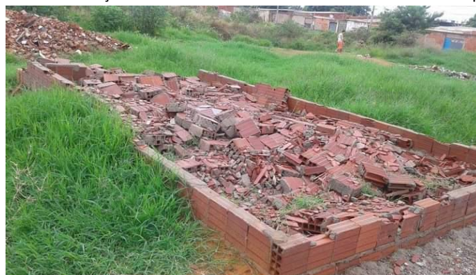
Figura 6: Restos de uma construção há menos de 10 metros de distância da nascente após denúncia, 2015.
