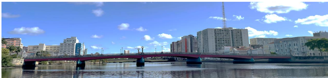
Figura 2: Vista panorâmica da fachada da Ponte Princesa Isabel, 2022.
