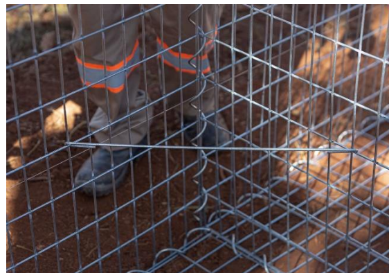
Figura 10 – Conexões dos gabiões eletrosoldados
