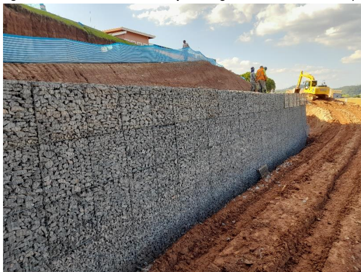
Figura 5 – Primeiro muro de contenção com gabiões eletrosoldados easy S
