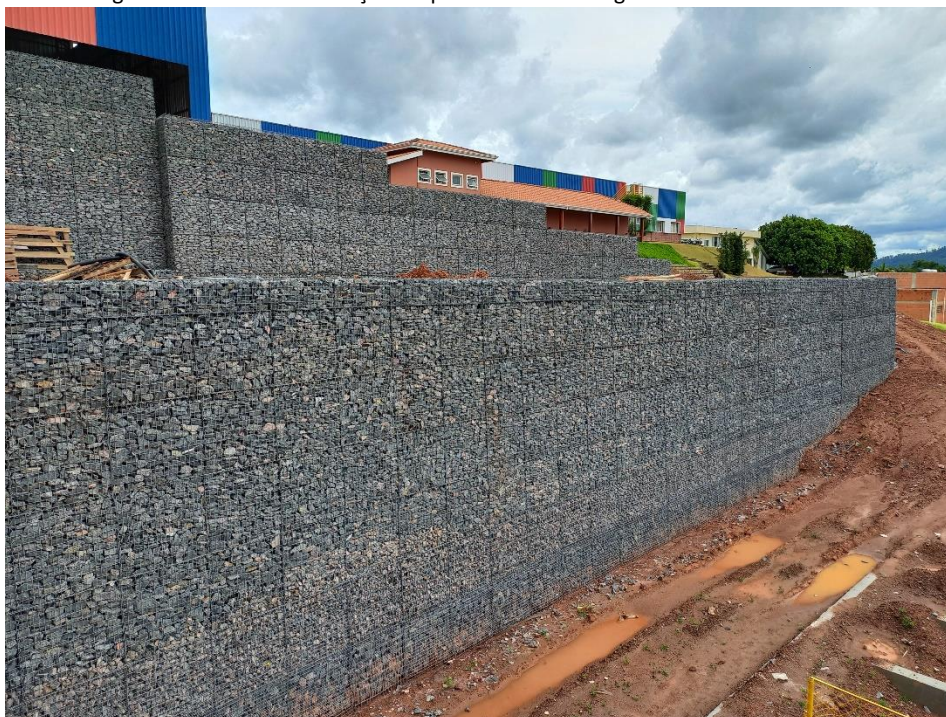
Figura 4 – Muros de contenção da primeira obra com gabiões de malha soldada
