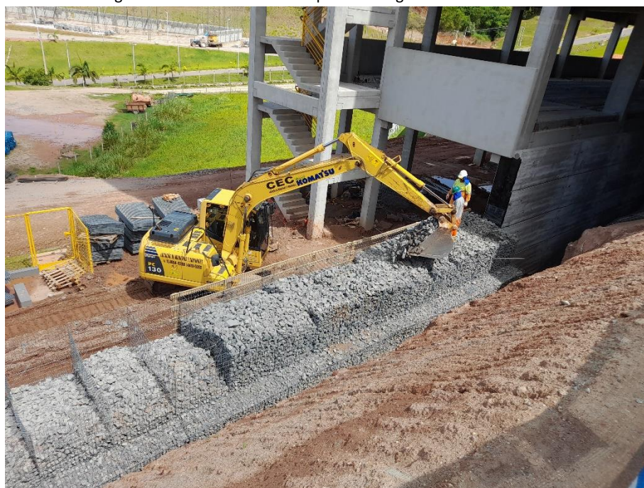
Figura 9 – Preenchimento com pedras dos gabiões eletrosoldados
