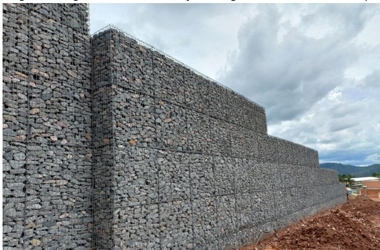
Figura 6 – Segundo muro de contenção com gabiões eletrosoldados easy S
