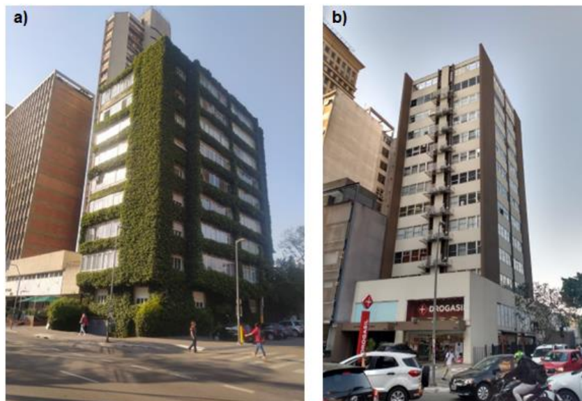
Figura 3 – Fachadas frontais (SO) e fachadas laterais (SE) dos edifícios CJV (a) e SJV (b)
