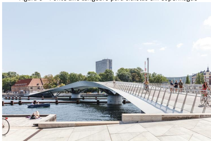
Figura 6 – Ponte Lille Langebro para ciclistas em Copenhague
