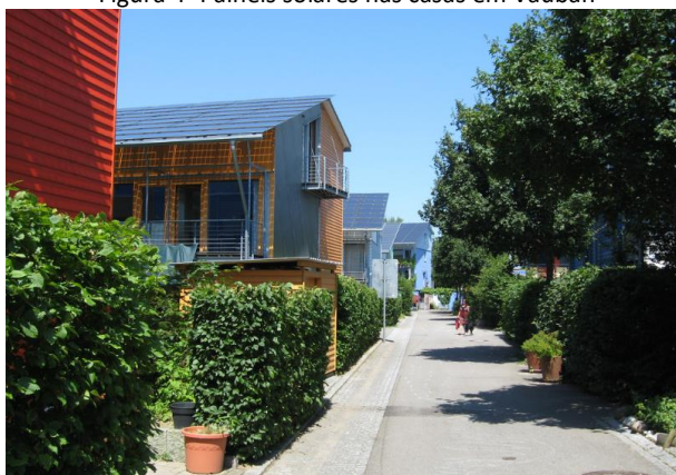
Figura 4- Painéis solares nas casas em Vauban
