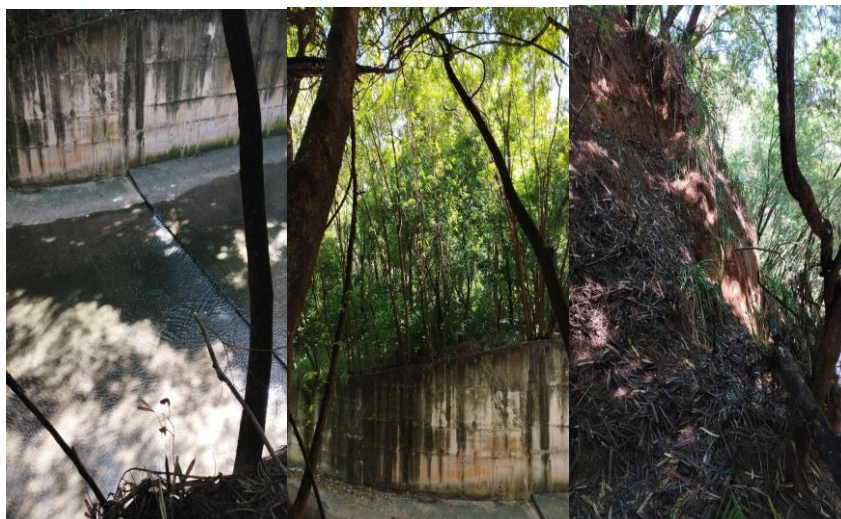
Figura 7 – Condições ambientais no trecho 4 do Córrego do Veado.
