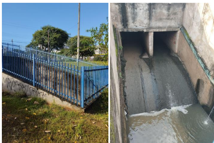
Figura 4 – Condições ambientais no trecho 1 do Córrego do Veado.
