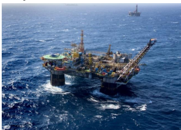
Figura 4 – Plataforma Semissubmersível Petrobras VII
