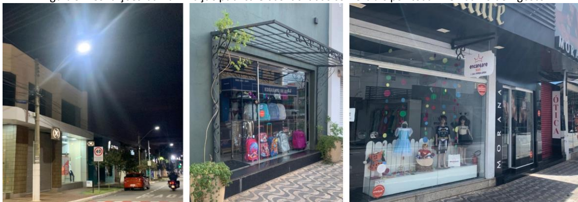
Figura 9 – Condições da iluminação pública e das fachadas comerciais por toda Avenida 20 de Agosto
