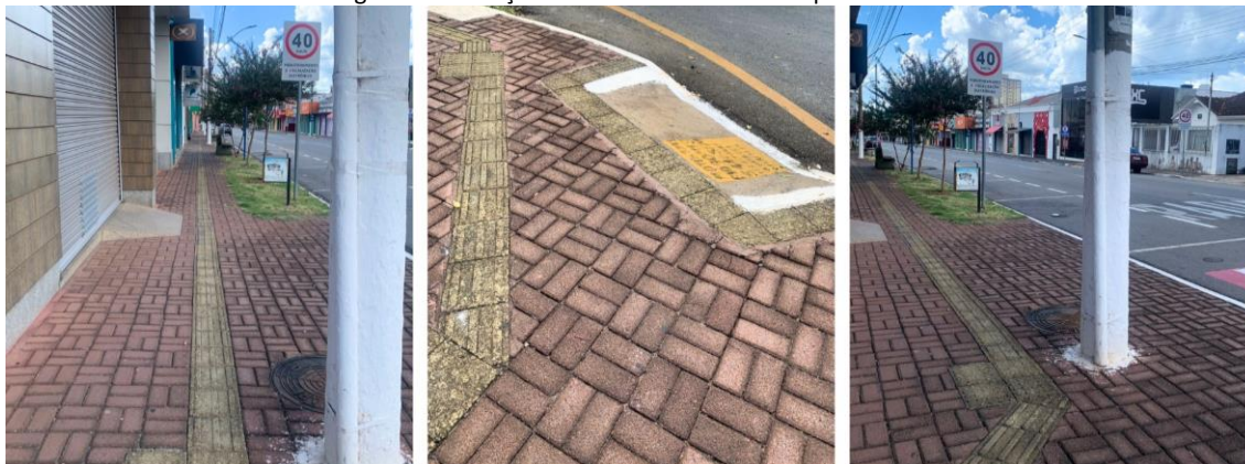
Figura 3 – Condições encontradas durante o percurso 1
