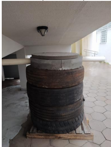
Figura 12 – Protótipo de fossa séptica ecológica
