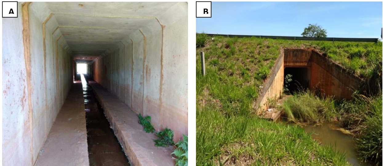
Figura 3- Passagens subterrâneas monitoradas durante o estudo. A- Modelo de passagem subterrânea do tipo galeria KM 560, utilizada na Rodovia Euclides da Cunha, localizada no município de Fernandópolis/SP, nas coordenadas de GPS 20°16'13.76"S 50°19'59.22"O. B- Entrada da passagem subterrânea do tipo galeria KM 609 com presença de mato e água empoçada, localizada no município de Estrela d'Oeste/SP, nas coordenadas de GPS 20°13'19.03"S 50°46'53.22"O
