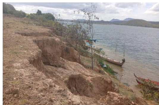
Figura 6 – Erosão no rio São Francisco
