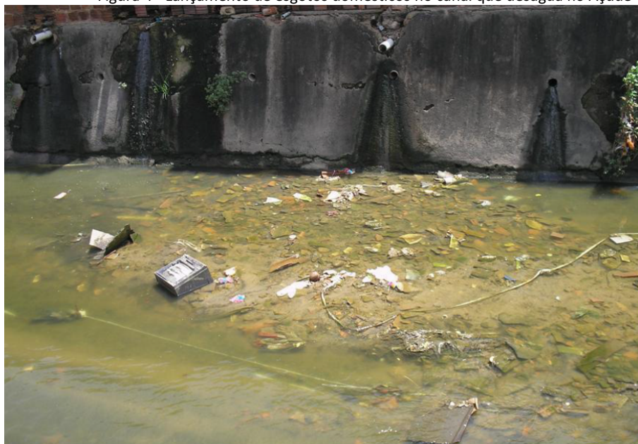
Figura 4 - Lançamento de esgotos domésticos no canal que deságua no Açude
