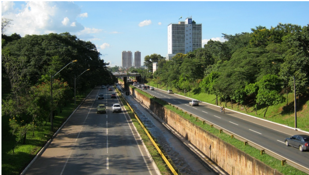
Figura - 1 Visão panorâmica da Marginal Botafogo dividindo o Parque botafogo
