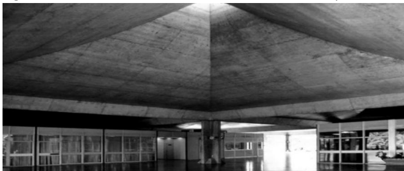
Figura 02: SUFRAMA-AM – Cobertura em coifa/domo parte interna
