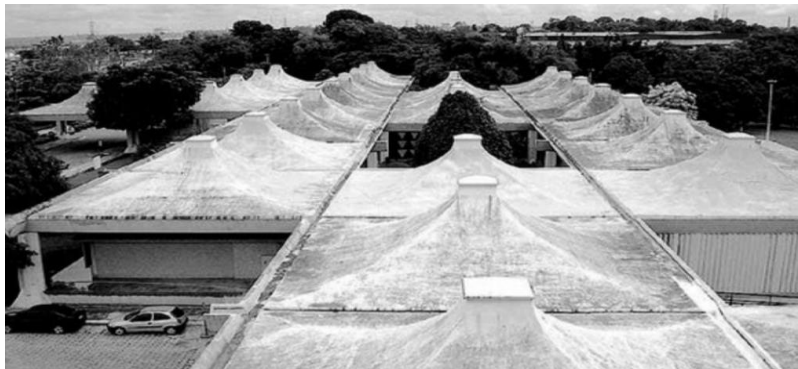
Figura 01: SUFRAMA-AM – Cobertura em coifa/domo parte externa
