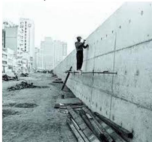
Figura 3 – Construção do Muro da Mauá na década de 1970
