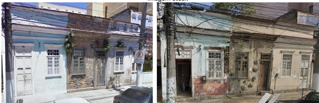
Figura 18 - Conjunto de imóveis que perderam a proteção, localizados à rua Visconde de Itaboraí, números 214, 216 e 218. À esquerda, foto de 2010, onde é possível observar o método construtivo da edificação central. À direita, imagem atual.
