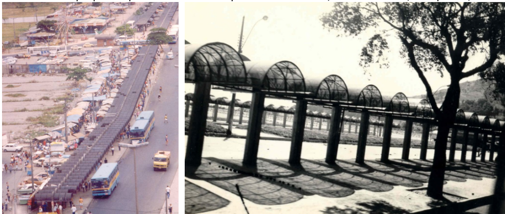
Figura 8 - Terminais propostos pelo CURA recém implantados. À direita, terminal Norte, à esquerda, terminal sul.
