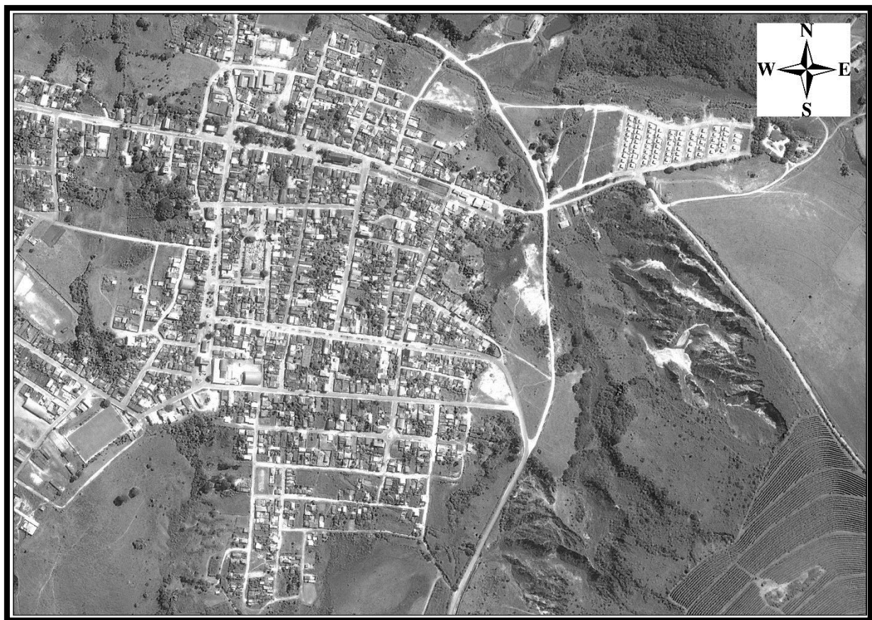
Figura 1. Vista aérea do município de Nazareno (MG), evidenciando à direita, a extensão e a proximidade da zona urbana de algumas das maiores voçorocas.
