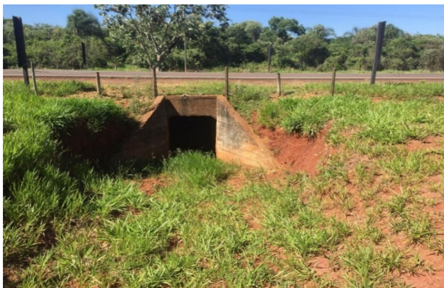
Figura 6: Túnel de passagem da fauna silvestre.
