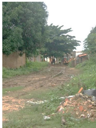
Figura 04. Rua sem Pavimentação do aglomerado Santo Afonso
