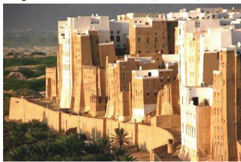
Figura 2: Edifícios em adobe, Shibam, Iémen
