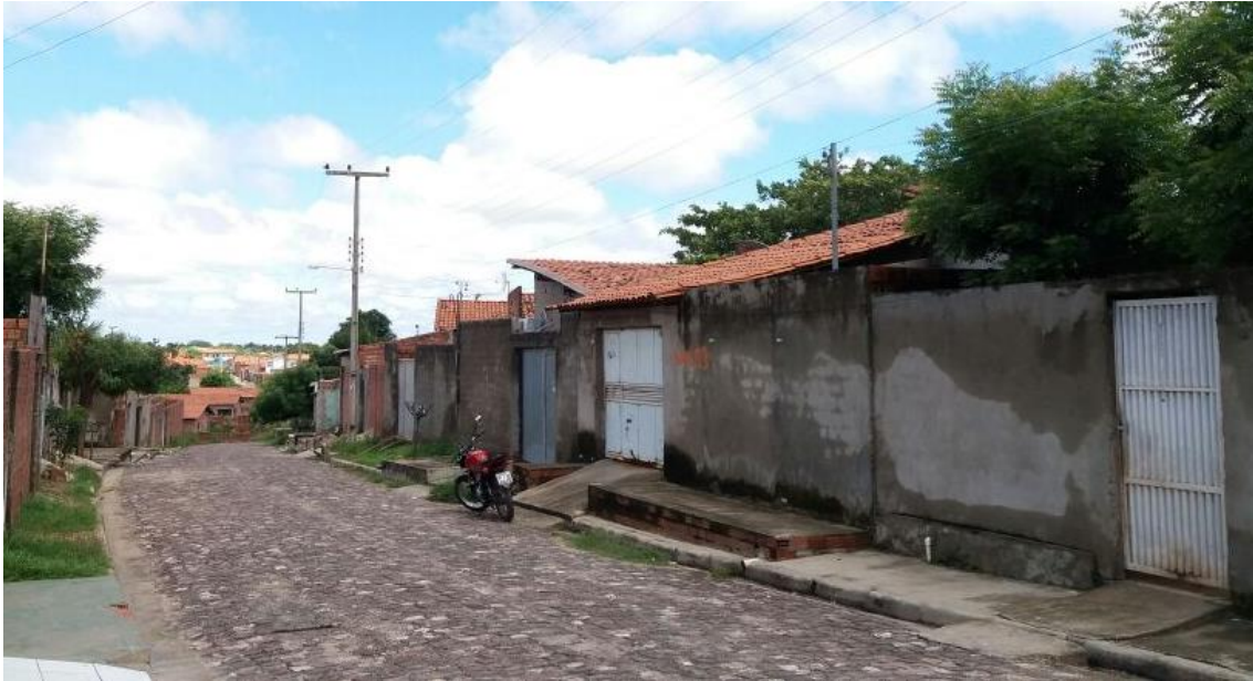
Figura 5: Tipologia arquitetônica ruas com calçamento do aglomerado Madre Teresa
