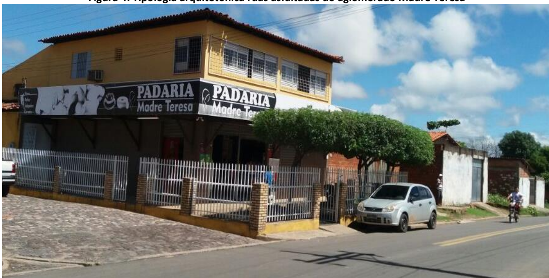
Figura 4: Tipologia arquitetônica ruas asfaltadas do aglomerado Madre Teresa
