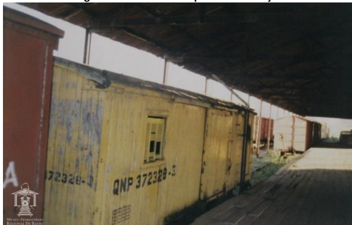
Figura 11: Barracão de apoio da baldeação
