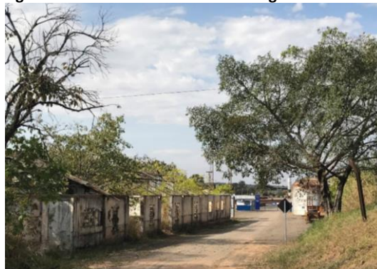
Figura 12: Usina da RUMO e o do antigo almoxarifado
