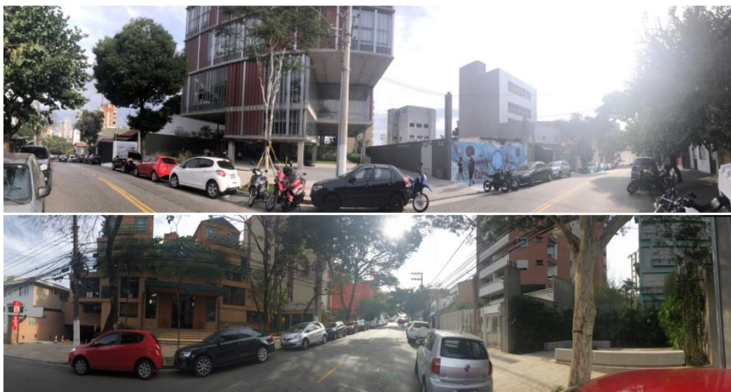
Figuras 5 e 6: Foto panorâmica com dos edifícios: POP+ (acima) e Módulo Fidalga (abaixo).
