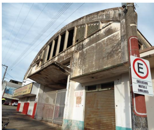
Ilustração 14: Edifício da antiga Rodoviária Acervo- SEPLIN-2012
