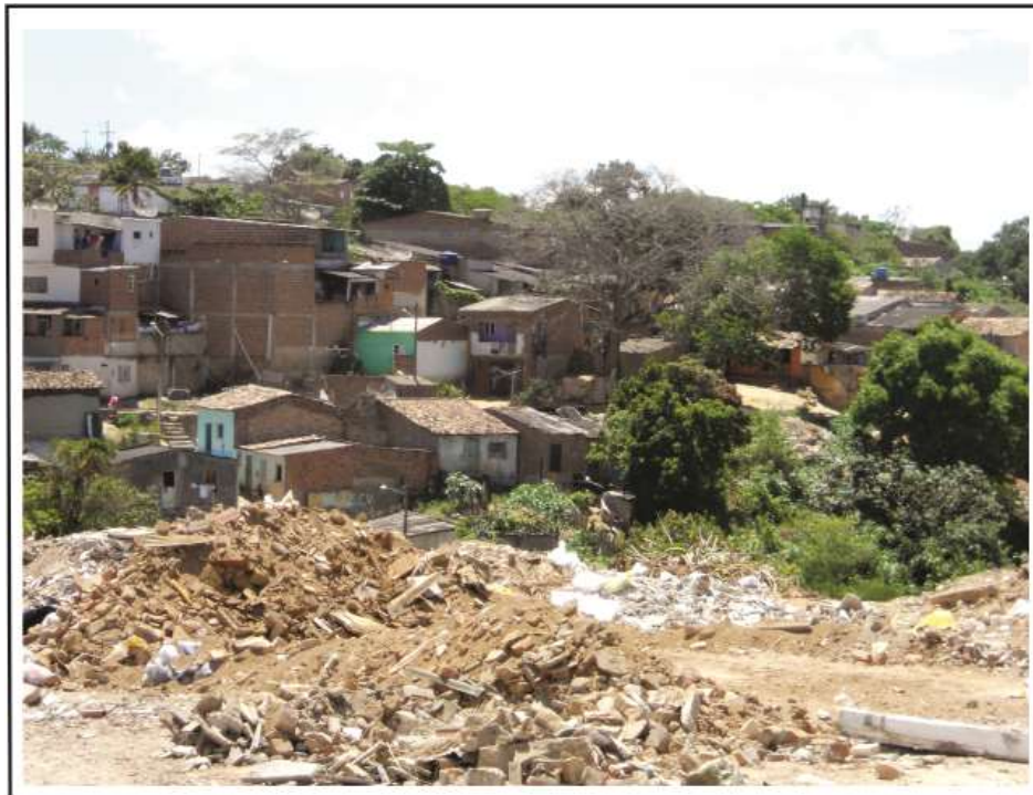
Figura 09 – Despejo de Detritos da Construção Civil em Encosta.
