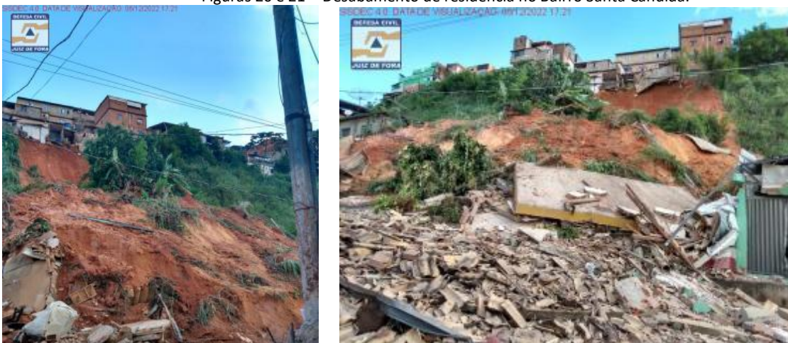
Figuras 20 e 21 - Desabamento de residência no Bairro Santa Cândida.
