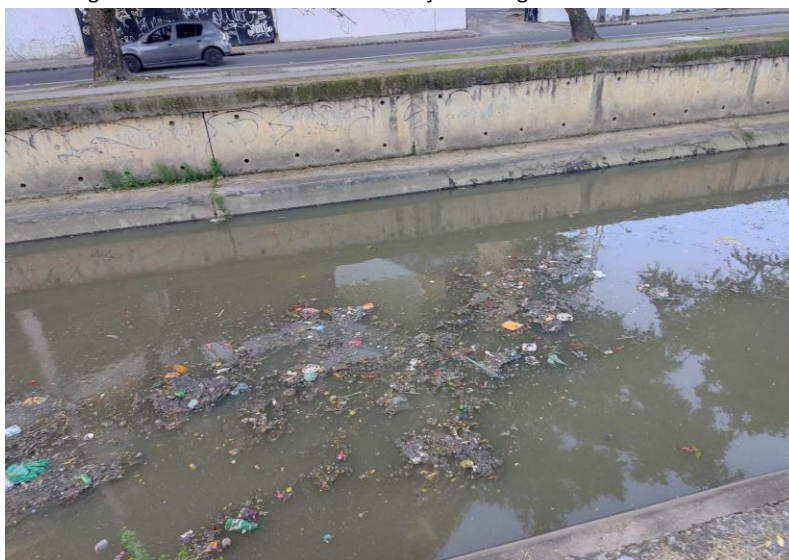
Figura 05 – Trecho em concreto e seção retangular- Canal do Arruda
