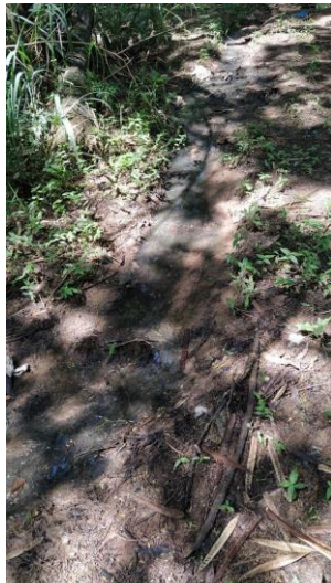
Figura 9 - Fonte de despejo de efluentes domésticos à montante do trecho 2 no Córrego da Unesp.
