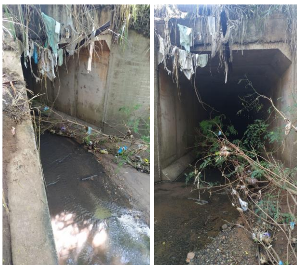
Figura 11 – Condições Ambientais no Trecho 1 do Córrego Vale do Sol, no período de chuva (esquerda) e seca (direita) de 2023.
