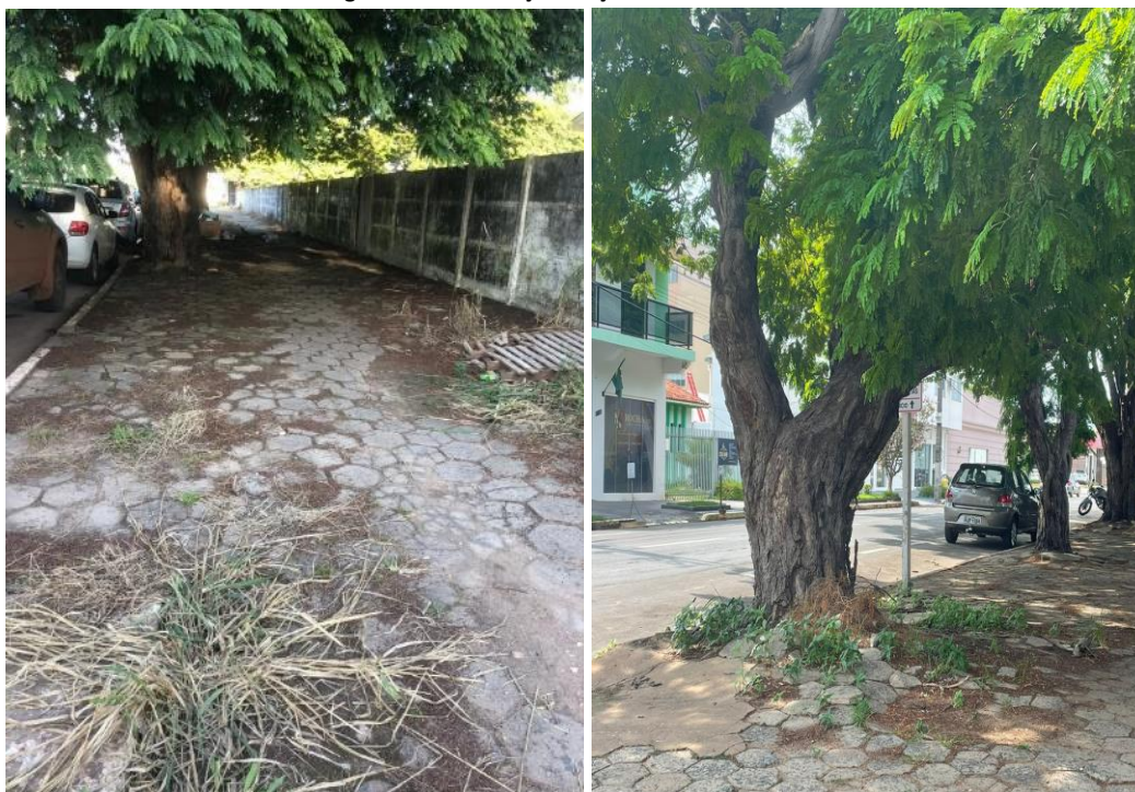
Figura 2 – Arborização calçamento deteriorado.
