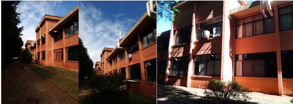
Figura 3 – Fachada Norte às 15 h de um dia de verão
