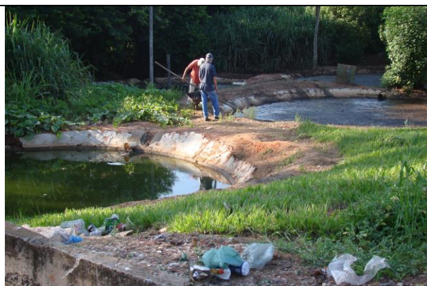
(6) Sistema de Tratamento de Efluentes.
