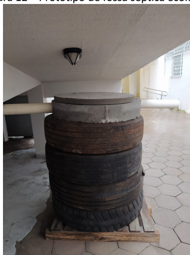
Figura 12 – Protótipo de fossa séptica ecológica
