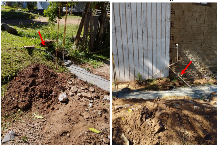
Figura 6 – Ligação clandestina de abastecimento de água
