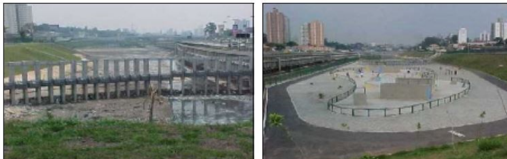
Figura 2: Bacia de detenção em São Paulo/SP
