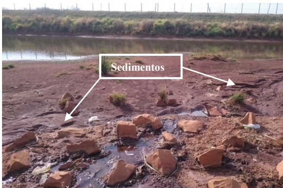
Foto 13: Bacia 2 – Sedimentos no fundo
