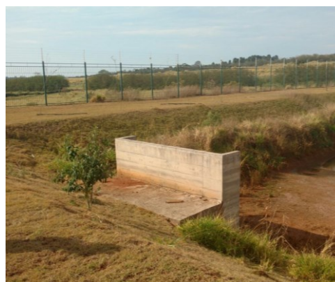
Foto 16: Bacia 2 – Estrutura de saída da água
