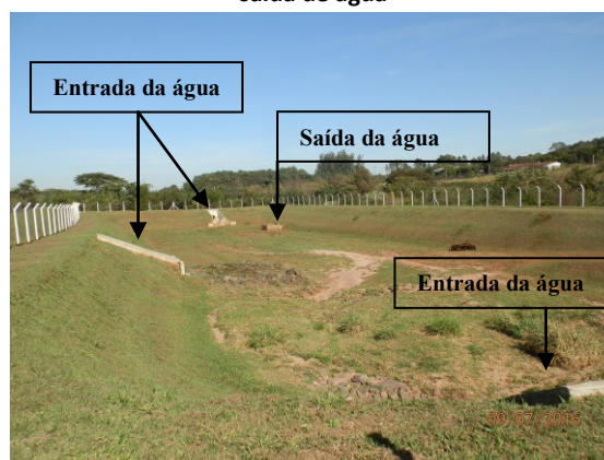
Foto 6: Bacia 1 – Estruturas de entrada e saída de água
