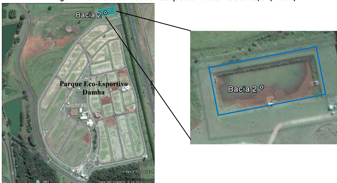
Imagem 2: Vista Aérea da Bacia de Detenção localizada em São Carlos/SP (Bacia 2)
