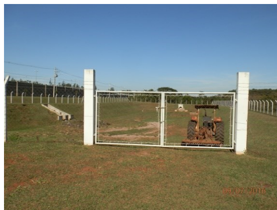
Foto 4: Bacia 1 – Acesso Controlado
