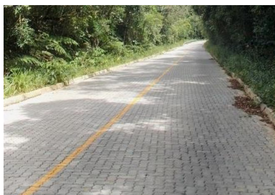
Figura 2. Revestimento articulado com blocos concreto pré-moldado na Estrada Parque Nequinho Fogaça.
