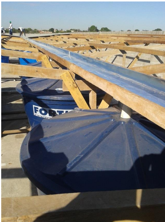
Figura 8- Detalhe de montagem das calhas e caixas de água pluvial
