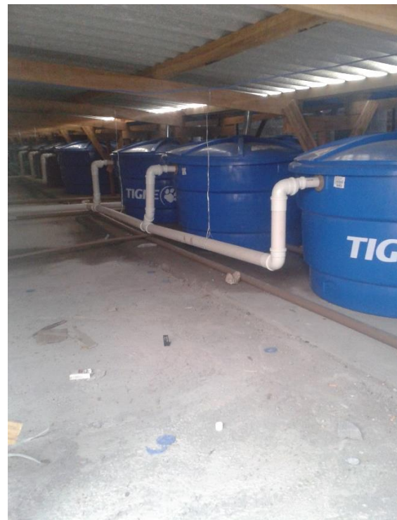
Figura 9- Detalhe Telhado pronto e dos extravasores
