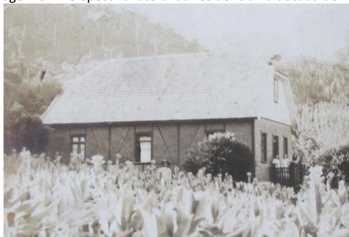
Imagem 02: Perspectiva lateral da residência na década de 1940
