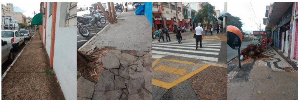
Figura 6 - Calçadas de Bauru (a) (b) (c) (d).
