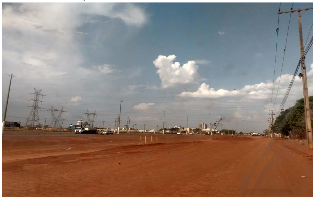
Fotografia 7 – Trecho em obras nas av. dos Estudantes
